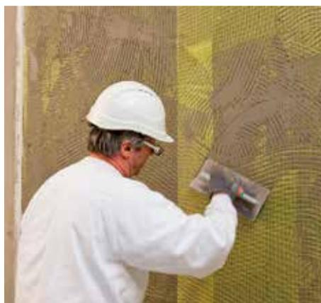
pannelli isolanti in corrispondenza delle aperture di porte o finestre. L'eventuale fissaggio meccanico supplementare deve essere eseguito, in corrispondenza della struttura metallica, attraverso la lastra.
